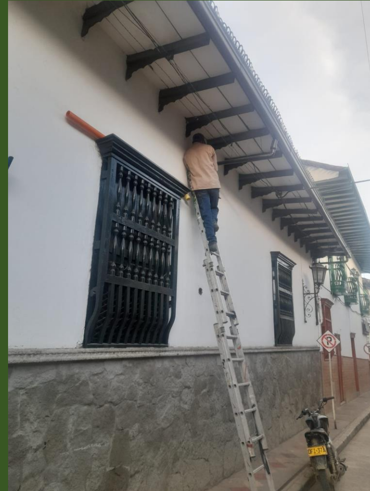
Mantenimiento de infraestructura con recursos propios
